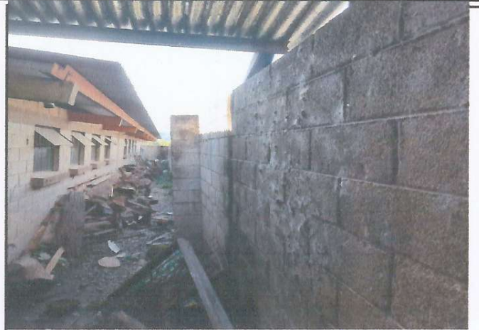
Foto 2: Mejoramiento de cercamiento Perimetral
