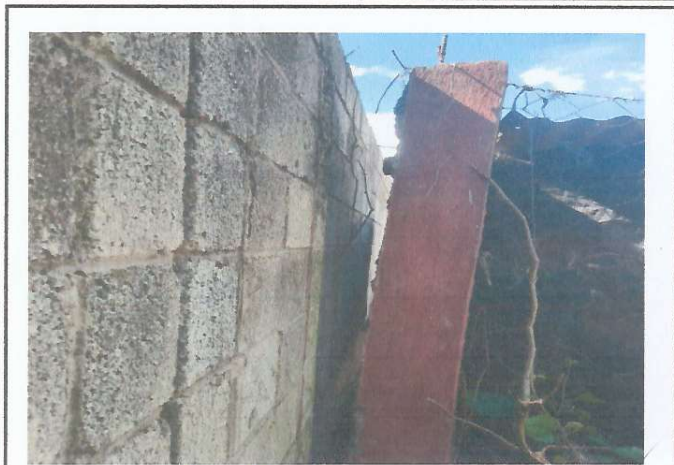
Foto 1: Mejoramiento de cercamiento Perimetral
