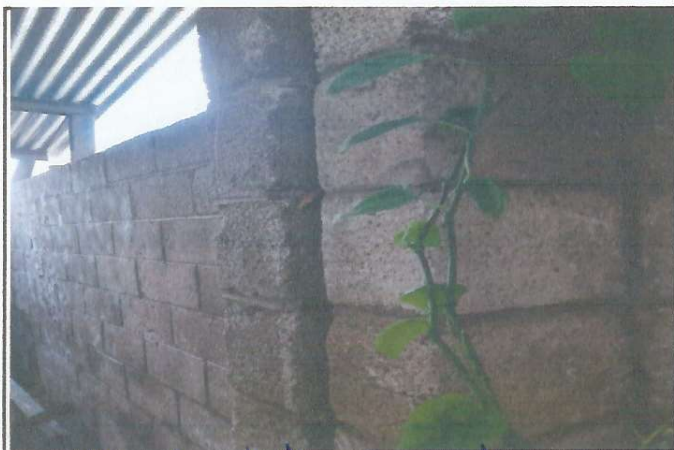
Foto 3: Mejoramiento de cercamiento Perimetral por desdome
